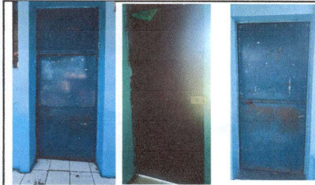
Foto 7: MANTENIMIENTO A ESTRUCTURA (LIJADO, CAMBIO DE TUBO, CEPILLADO, APLICACIÓN DE PINTURA)
