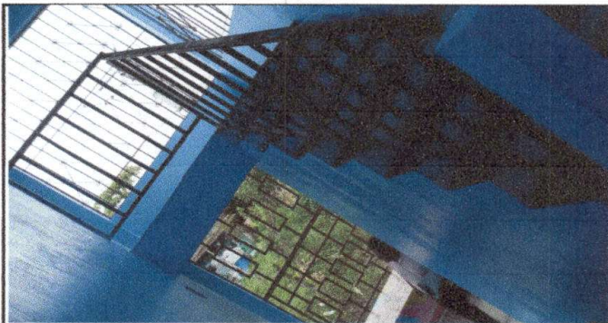
Foto 6: SUSTITUCION DE BARANDAS DE METAL
