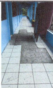
Foto 5: SUSTITUCIÓN DE DE PISO CERAMICO
