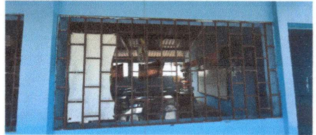
Foto 8: MANNTENIMIENTO DE BALCONES DE METAL
