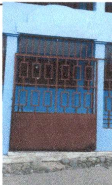
Foto 3: SUSTITUCIÓN DE PORTON DE METAL
