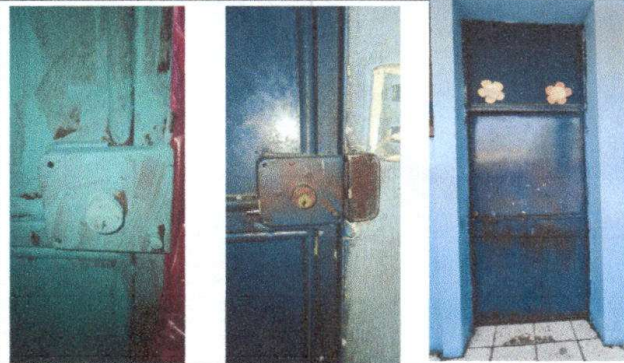
Foto 2: SUSTITUCIÓN DE CHAPA
