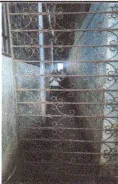
Foto 9: SUSTITUCION DE BARANDA DE METAL DE PUERTA
